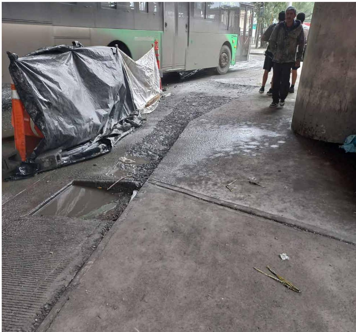
271. **Estación Moderna.** - Se encontró al momento de la visita un área de trabajos de construcción en la que no se observó señalización de seguridad. Asimismo, se observó un registro de servicios abierto, como enseguida se aprecia:
