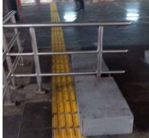
126. Cabe subrayar, que los módulos del piso podo táctil con que cuenta dicha estación, sus dimensiones son de 0,20m por 0,20m; lo recomendable es tener como mínimo módulos de 0,30m por 0,30m y máximo 0,40m por 0,40m.
