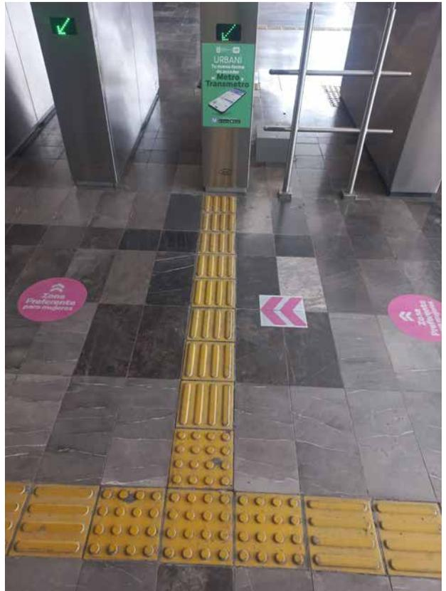
289. Las 8 estaciones de la Línea 3 **en los andenes** cuentan con una **franja de pavimento (aviso táctil)** colocada a una distancia de 0,50m del borde del andén, sin embargo, no en todas las estaciones cuenta con cambio de textura y el ancho de la citada franja es de 0,11m. Lo recomendable en la actualidad son las siguientes medidas: Para desniveles menores a 60 cm franja de 30 o 40 cm y para desniveles mayores a 60 cm franja de 40 o 60 cm.
